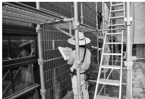
(写真2) 打診調査の様子
